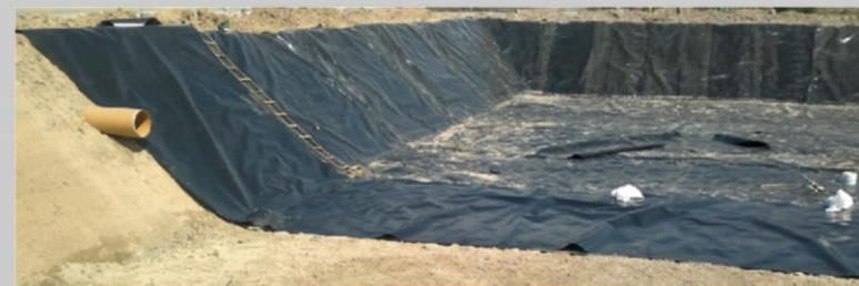
Zdj. Zbiornik w trakcie realizacji umocnienia bentomata (źródło: http://www.aknova.pl/pl/Podstrony/Oferta/Wykonastwo/Us-ugi-specjalistyczne-w-zakresie-uszczelniania-ob )
